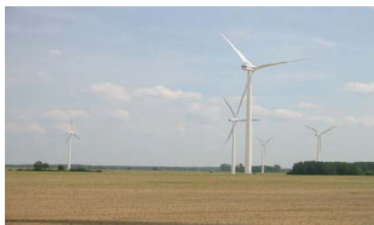
Rys. 2. Turbiny V80 na farmie Zagórze
